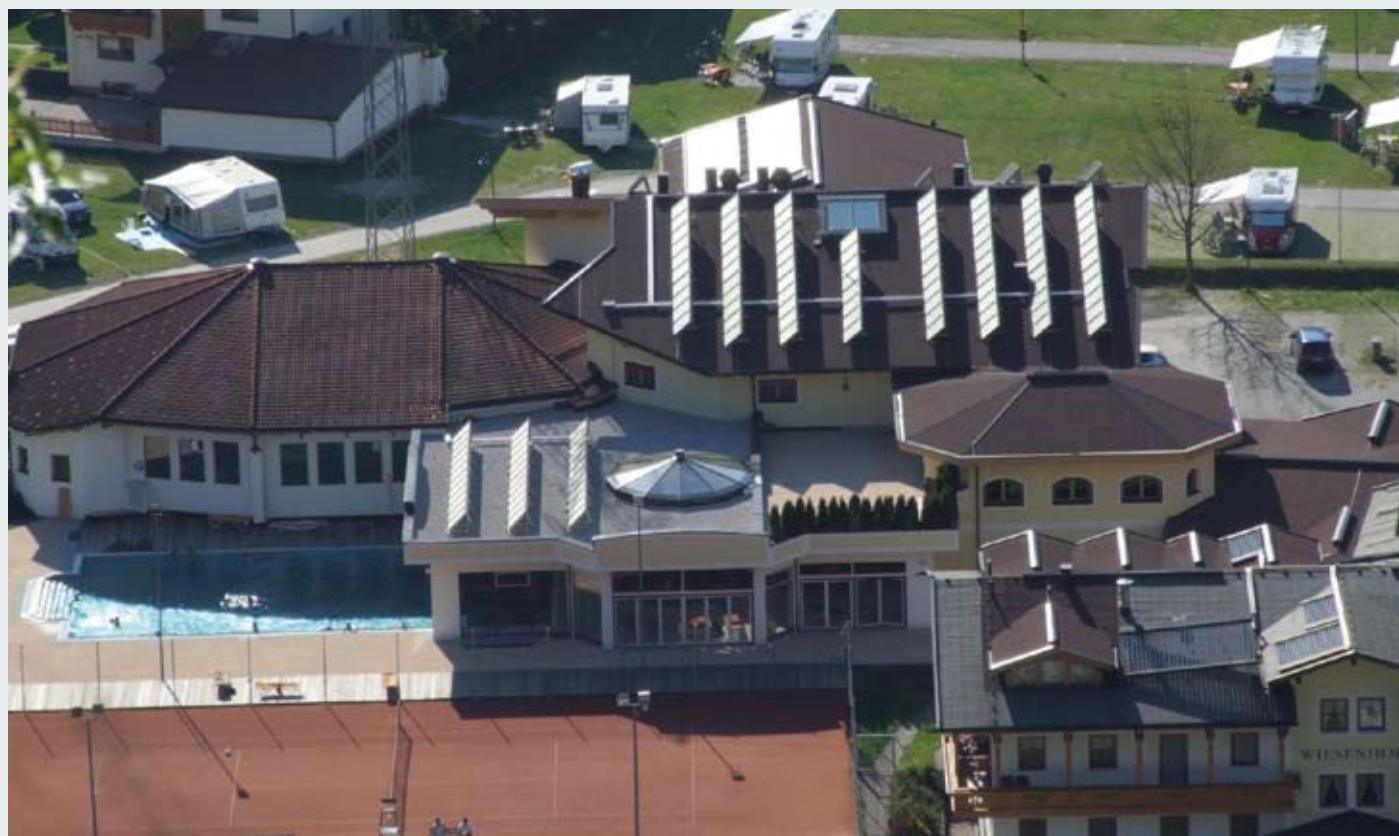
Colectores de grandes superficies FA instalados para camping
